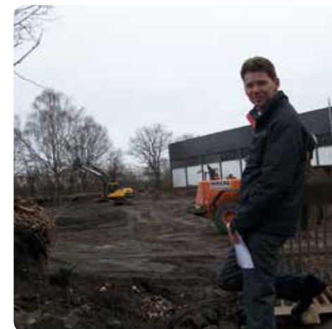
Thomas Armbrecht begutachtet die Baustelle
